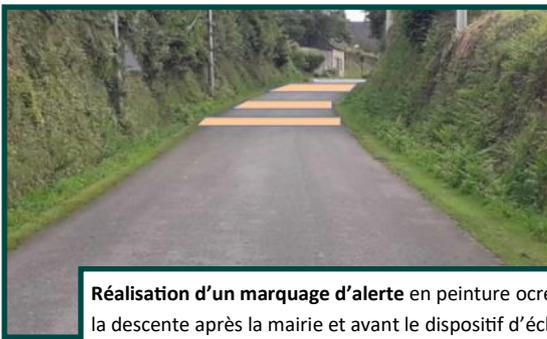
Réalisation d'un marquage d'alerte en peinture orange dans la descente après la mairie et avant le dispositif d'écluses
